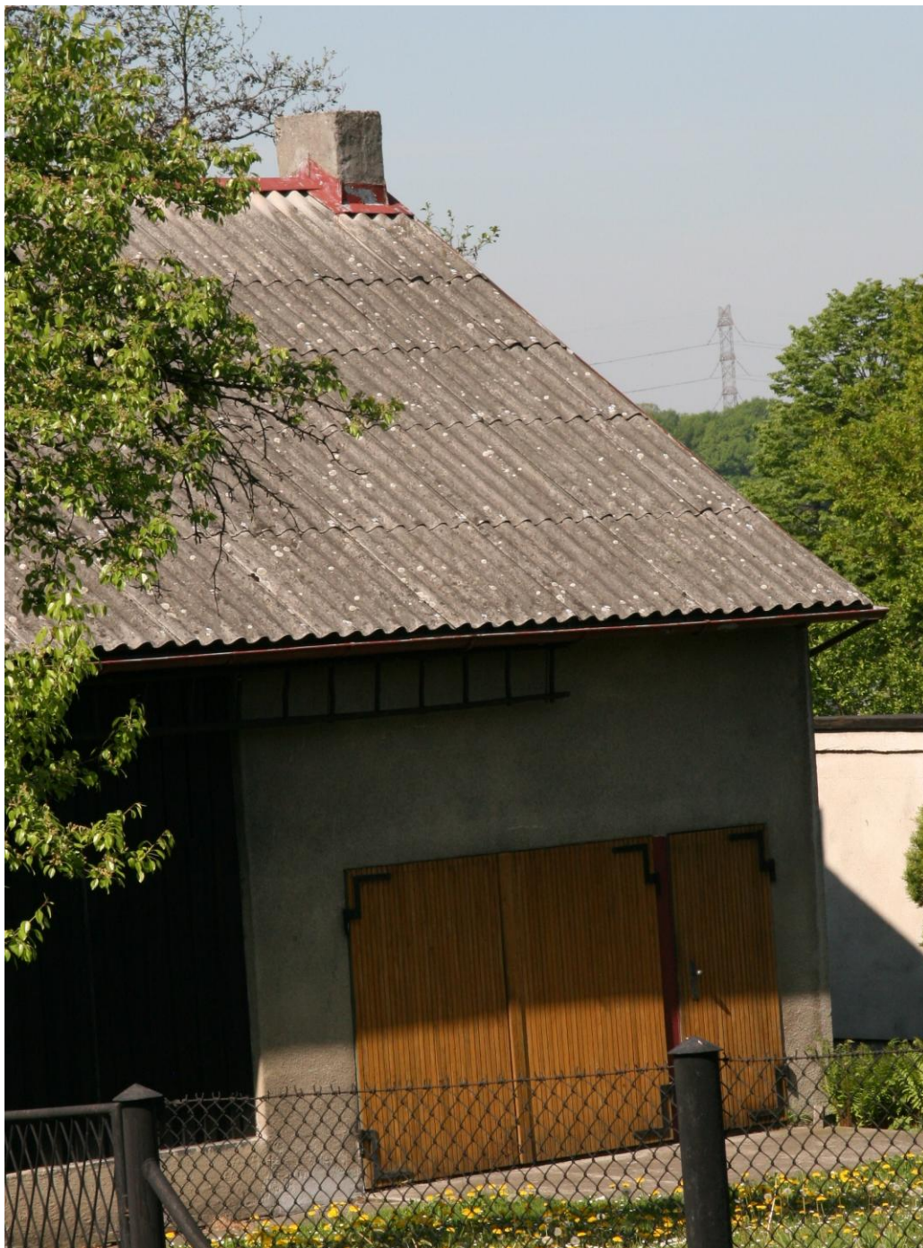
Rysunek 3 Dach pokryty płytami azbestowymi falistymi
