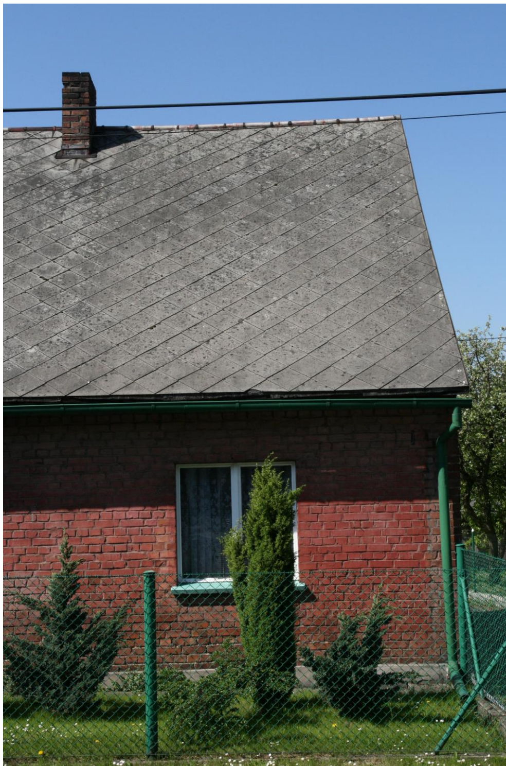
Rysunek 6 Dach budynku mieszkalnego pokryty płytami azbestowymi płaskimi
